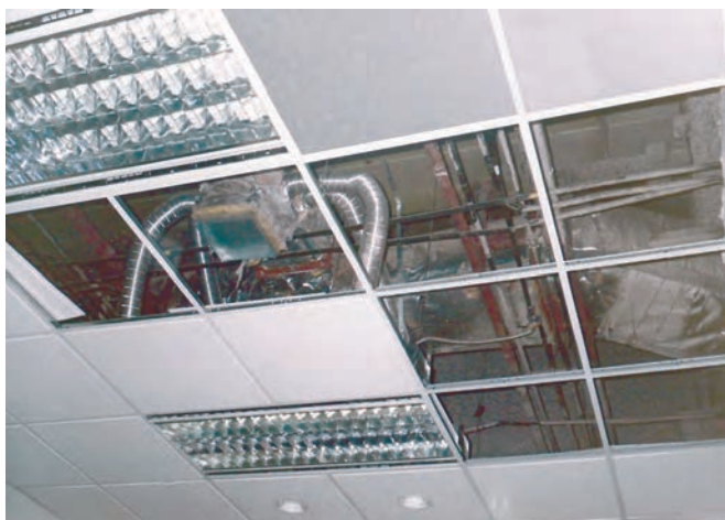
تصویر ۲۰ - زیر سازی سقف کاذب
