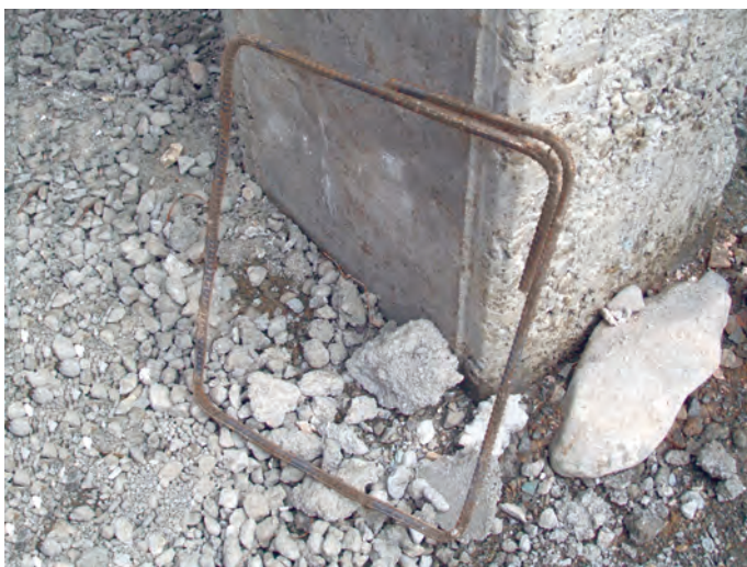
تصویر ۷ — نمونه‌ی یک خاموت
