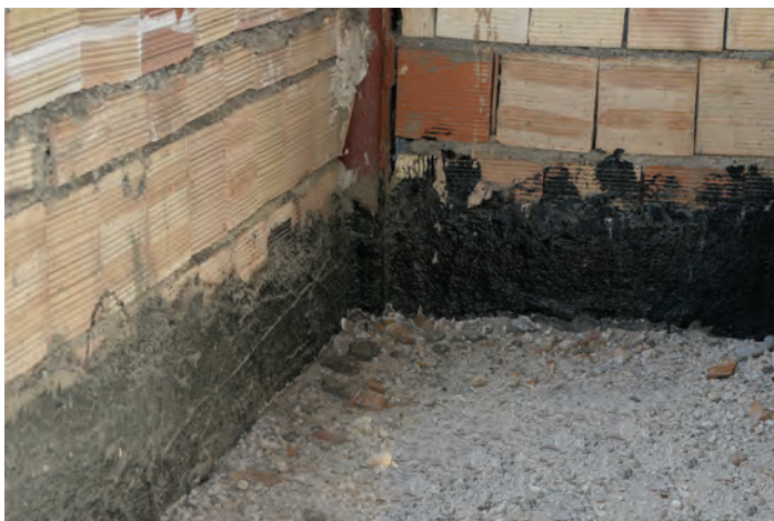
تصویر ۱۶ - عایق کاری کف سرویس بهداشتی
