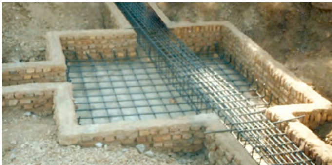
تصویر ۶ — نحوه‌ی قرارگیری میل‌گردهای کف پی (مش) و آرماتورهای شناژ
