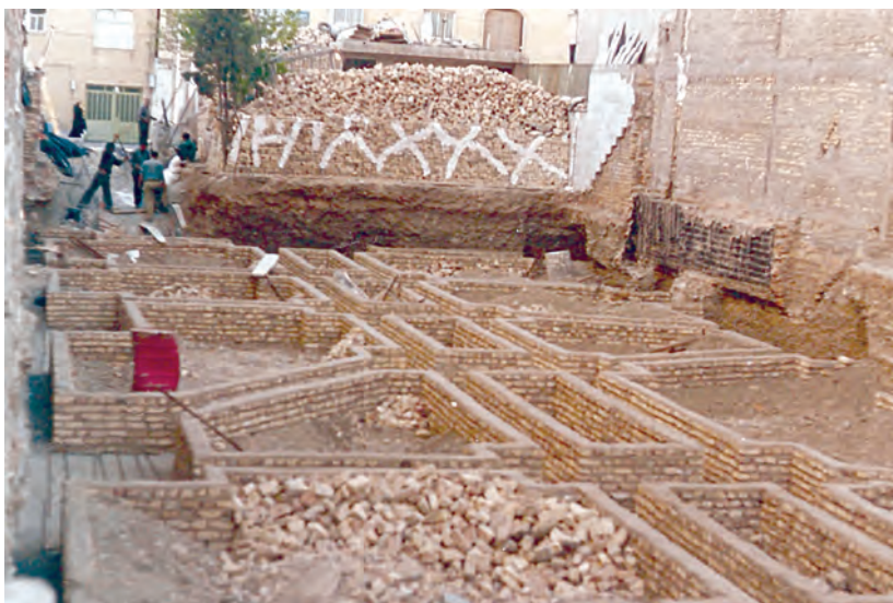
تصویر ۵ - قالب بندی آجری بی ساختمان
