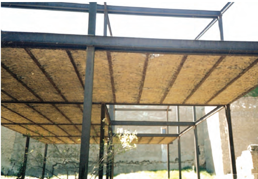
تصویر ۱۰ - تیرریزی سقف طاق ضربی
